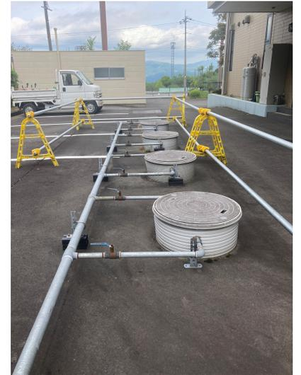
広大な研修施設の中の「富士倫理学苑」などを、既存の浄化槽（88人槽）を活用して曝気。浄化槽の悪臭は無くなり、複合発酵技術により処理された水を植物に散布する中水として利用することで、水のリサイクルを実現し、草木が生き生きとしています。また、毎年数百万円の費用をかけて池の汚泥処理を行なってきましたが、設置後はその必要がなく、池の水は透明になりました。
