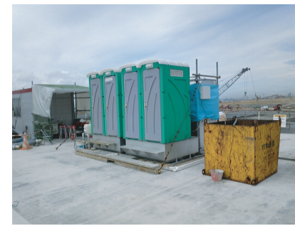
羽田空港再拡張工事現場（鹿島建設）
