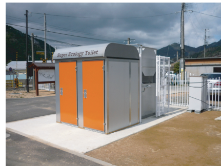
養父市「やぶこいの街公園」 発注者：兵庫県養父市建設課 設置年月：平成20年12月
