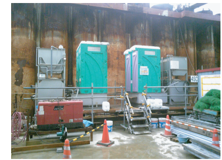
羽田空港再拡張工事現場（清水建設）
